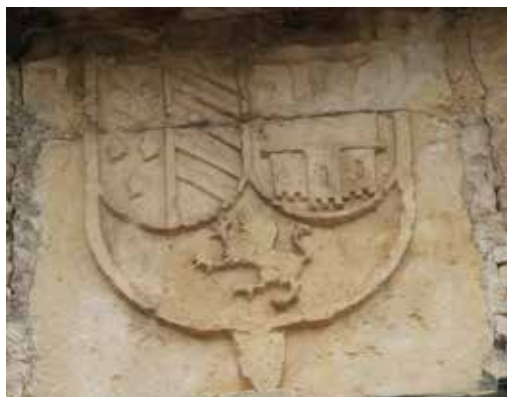
Fig. 12 - Escudo del «Palacio Miñano». Nótese como la parte superior apenas ha quedado visible debido, principalmente, a la disposición de un balcón que se añadió a línea de la fachada y que forma parte de las modificaciones posteriores que se realizaron sobre la misma.
