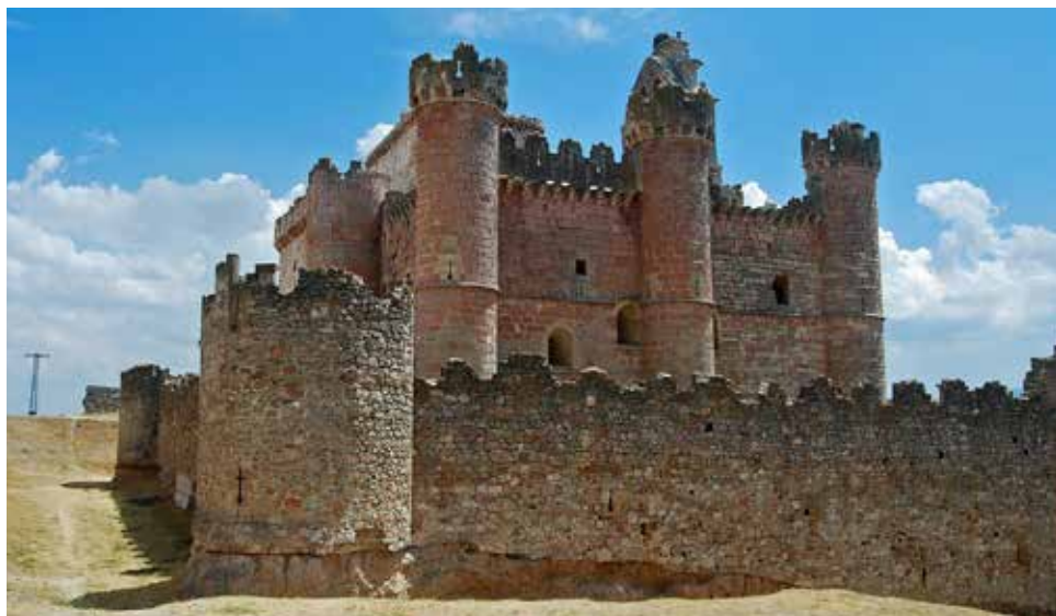
Fig. 4 - Muro oeste del castillo. Contraste en las sillerías de la fachada oeste. Obsérvese la variación de la calidad en la sillería de la misma fachada. De un lado, el muro erigido por el obispo Arias Dávila (zona derecha); de otro, el lienzo levantado en el pontificado de Arias del Villar (zona izquierda). Fotografía obtenida del directorio www.flickr.com .
