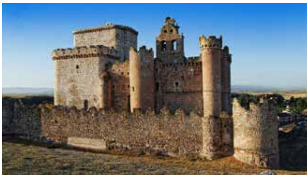
Fig.8 - Muro norte. Diferencia de estilos entre las torres de Juan Arias Dávila, izquierda; el cubo del vértice noroeste y resto de lienzo promovido por Juan Arias del Villar, derecha; y, finalmente, el muro central con el cubo adosado que porta el escudo de su promotor Diego de Ribera. Imagen obtenida del directorio: http://www.descubrecoca.com/2011/07/castillo-de-turegano.html (consulta: 22/ 01/ 2013)
